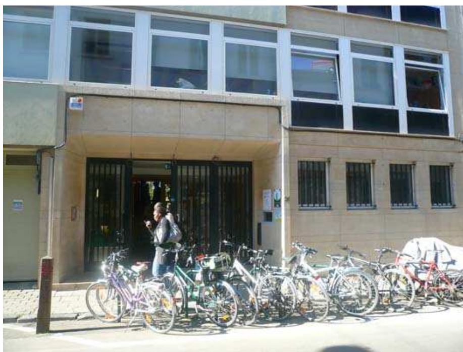
Le parking à vélo devant l'entrée de l'immeuble Mundo Bruxelles
